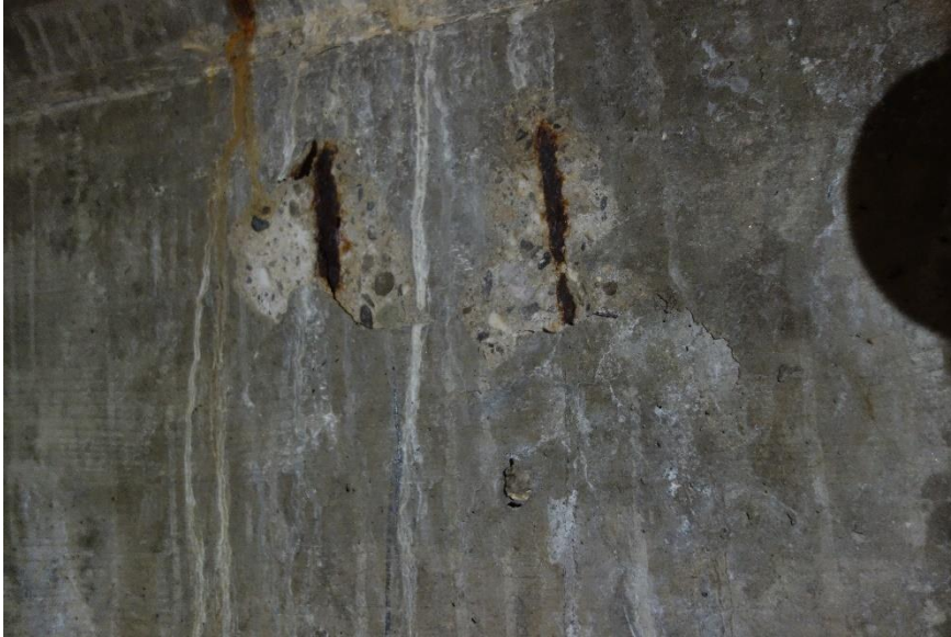
Betonschäden Beckenkörper
