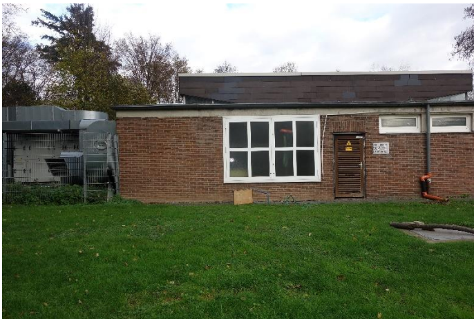
Fenster Techniktrakt mit außen angebrachten Bändern, offensichtlich jedoch nicht als Notausgang qualifiziert. Darüber „schwebt“ das Dach über der Schwimmhalle.
