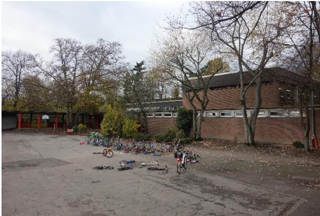
Bauliche Gesamtsituation Turnhalle / Lehrschwimmhalle
