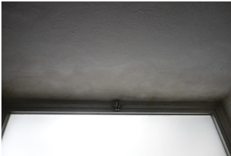
Feuchteschäden Fenstersturzbereich
