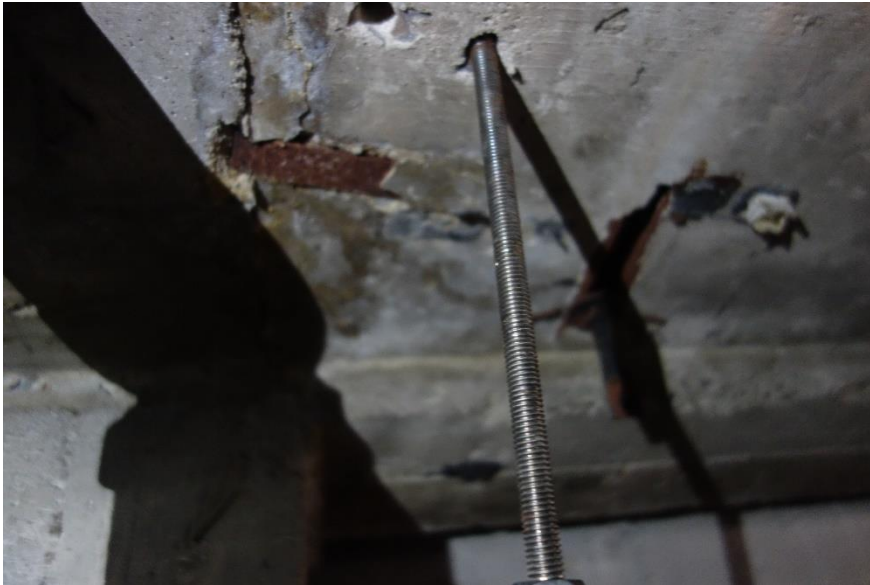
Betonschäden Deckenbereich
