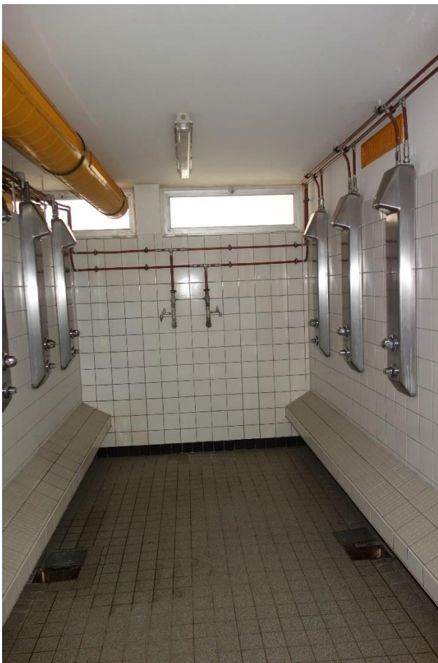
Duschraum mit erkennbarer Aufputz-Installation
