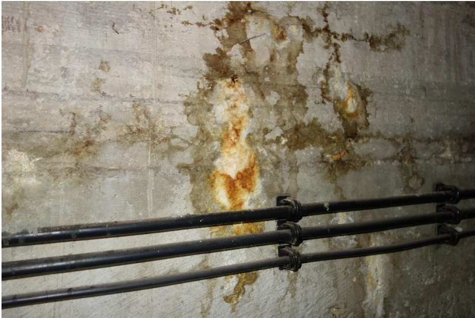
Betonschäden Lehrschwimmbecken
